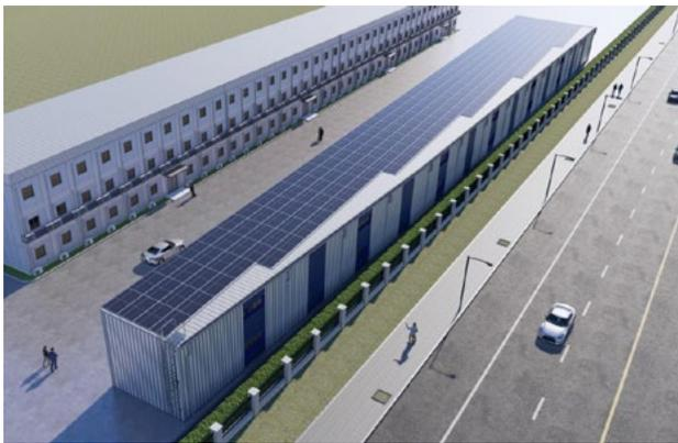
该建筑主体为钢结构，屋顶采用精工工业 BIPV 建筑光伏一体化屋面系统设计方案，在原金属屋面围护系统设计方案基础上充分融合分布式光伏系统，采用 655W 双玻组件替代传统金属彩钢瓦。
