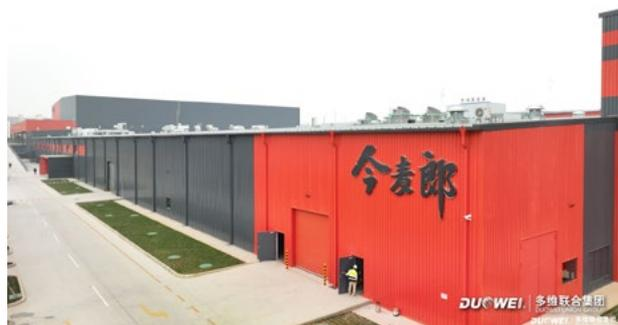
今麦郎饮品（扶绥）饮料生产项目一期用地 124 亩，主要生产超洁净凉白开、无菌饮料。该项目应用多维 DW-19 金属屋面系统 5 万 $\text{m}^2$ 、OTW1000 型压型钢板系统 20600 $\text{m}^2$ ，以及楼承板系统钢结构等产品。
