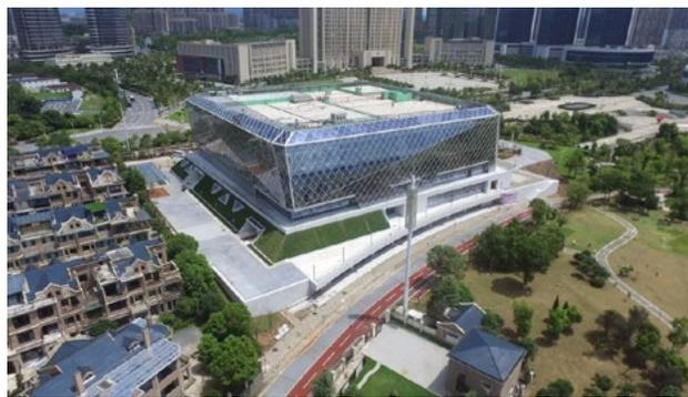
工程采用 331 根机械旋挖灌注桩，桩基承台基础，经检测，1 类桩达 100%，单桩承载力检测满足设计要求；地下防水采用预铺反粘防水技术；采用高强钢筋技术、高强钢筋直螺纹连接技术以及预应力技术；高大模板采用销键型盘扣式脚手架及支撑架；屋面防水保温中规中矩，各种设备布局合理；地下室水泥自流平地面光滑平整，结实耐磨，标志清晰；大堂墙地面铺贴平整，色泽均匀，接缝整体严密，圆形立柱饰面精美，高大挺拔；公共走廊地面防滑抛光地砖排版规整合理，无空鼓；木门开启灵活，油漆色泽均匀；内墙采用沸石壁材，天然环保，美观大方；吊顶风格多样，造型美观，层次分明，做工精细，灯具、喷淋、烟感等安装牢固，居中布置，成排成行；卫生间墙、地面瓷砖铺贴美观，拼缝严密，无色差，洁具布置合理；各类机房设备安装利用 BIM 技术进行优化，排列整齐，安装牢固，运行良好；管道桥架立体分层，标示醒目，穿墙管道周边防火封堵严密；配电柜箱安装整齐规范；报警、监控等弱电智能化系统集成度高，系统可靠性好；各类防雷接地连接规范，准确可靠；电梯厅前室门套美观大方，电梯运行平稳，平层准确；建筑物全高垂直符合规范要求，沉降均匀稳定。
