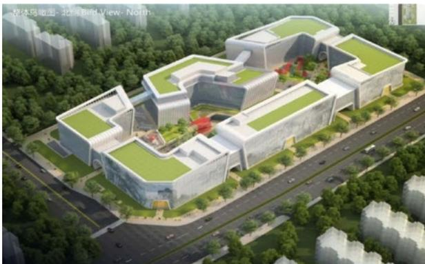
北京巨山创意园项目（1#绿隔产业用房等11项）位于北京市海淀区四季青镇巨山村，总建筑面积13.86万平方米，地上5-6层，地下3层，整体由6栋独立建筑和6座连廊构成，机施集团承担北区3栋主体建筑（1号、2号、6号楼）和3座连廊钢结构施工。钢结构施工中，解决了钢结构与混凝土组合劲性结构体系施工、落地连廊与钢框架倾斜柱施工、大跨度不等高折线形空中连廊桁架加工制作与安装等难题，巨山创意园项目已获得北京市建筑（结构）长城杯金质奖。
