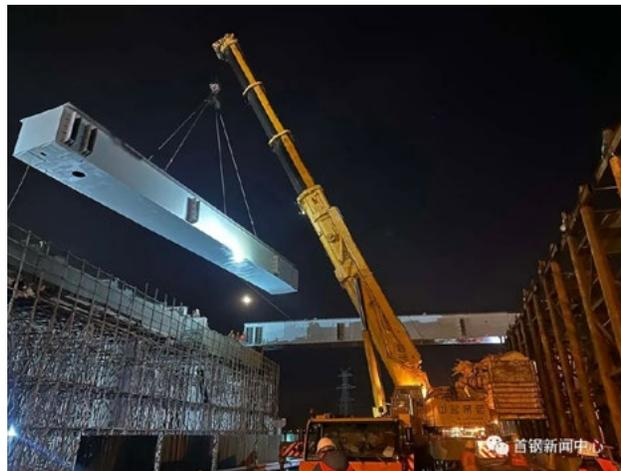
2月14日凌晨3:00，由首钢建设钢构公司承揽的京雄高速跨南五环段钢箱梁顺利完成首吊架设，标志着京雄高速转入跨五环路施工进入到关键阶段。14日凌晨，承载着钢箱梁的2辆构件车、500吨汽车吊及3辆配重车缓缓开进施工路段，进入预定位置，管理及施工人员各负其责，精准把控，最终在全体管理及施工人员的默契配合下，2段钢箱梁精确安装到位，顺利完成了“保一段争二段”的首吊任务。
